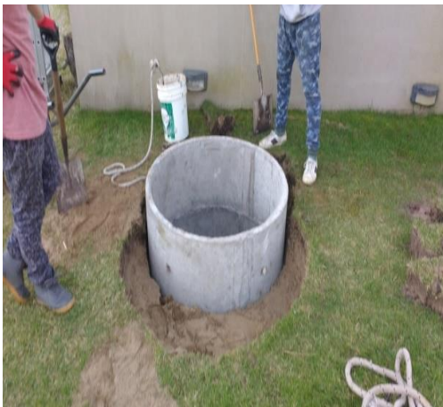
o) Pozos cloacales realizados en residencia propia en la ciudad de Pinamar. Fuente: Elaboración propia, Tomada el 10/7/19.
