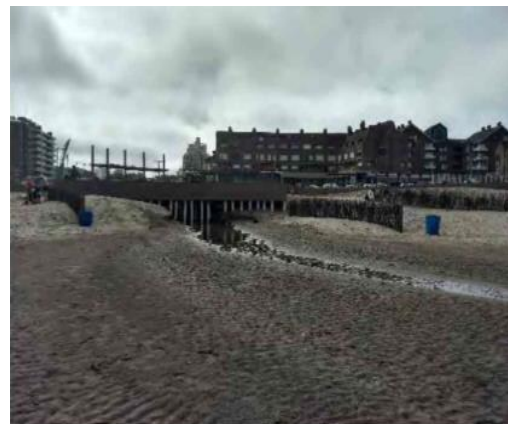
p) Pileta de derrame de líquidos cloacales sin tratamiento y desagües pluviales que conducen residuos a la playa junto con el excedente del agua de lluvia en Pinamar. Año: 2018. Fuente: Velazco (2019).
