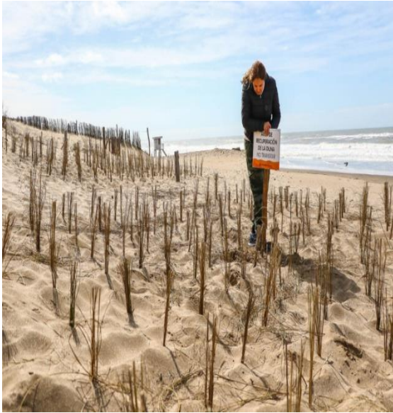
t) Trabajo de enquinchado y reparación de duna. 6 Fuente: Elaboración propia. Tomada el 5/1/2021.
